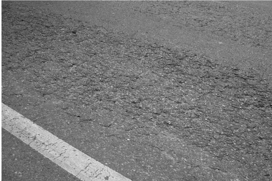
รูปที่ 2.7 การหลุดล่อน
