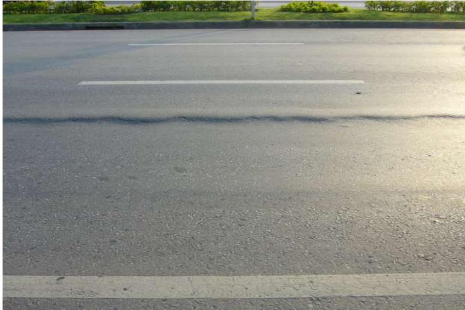
รูปที่ 2.2 การปูถนน
