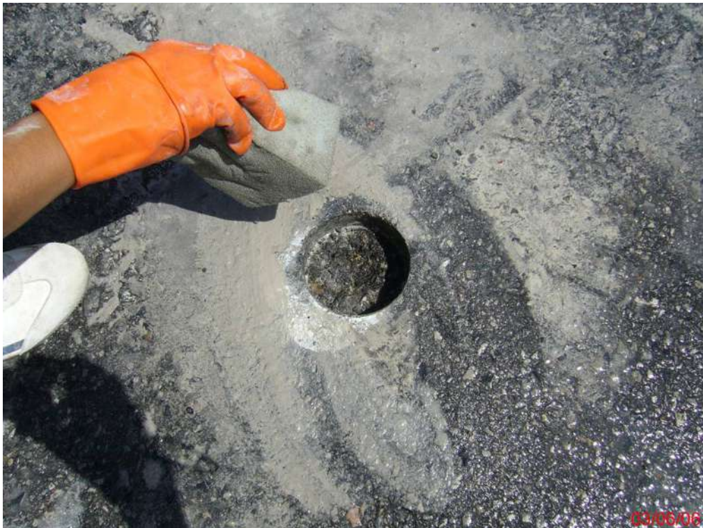
รูปที่ 3.8 การทำความสะอาดพื้นที่ก่อนการอุดหลุมเจาะด้วย Cold Mix Asphalt
